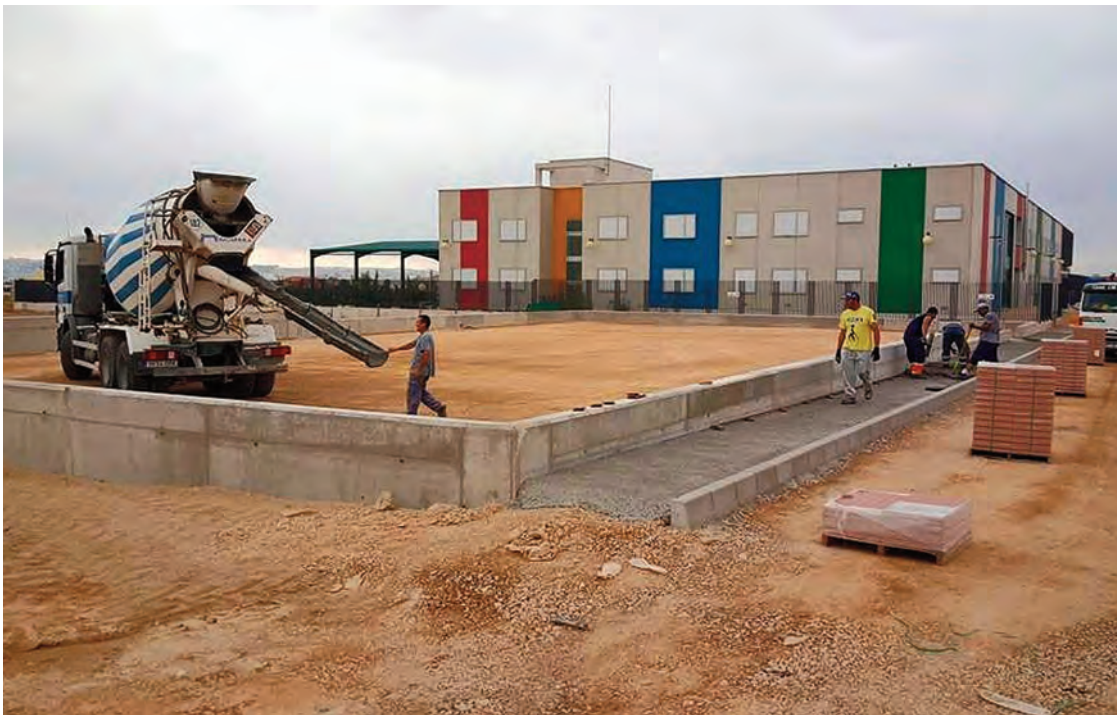
Esta instalación está situada junto al instituto "La Florida" y contará con cancha de fútbol y de baloncesto.
