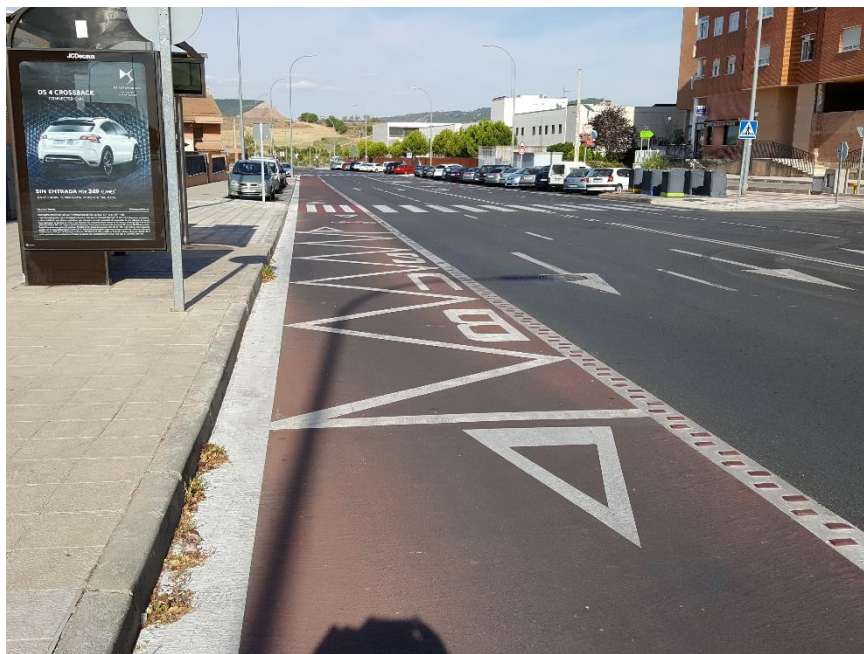
Planta del diseño de un carril bici cuando cruza una parada de autobús sin aparcamiento (izquierda). Aplicación práctica en Av. Salinera de Guadalajara (derecha)
